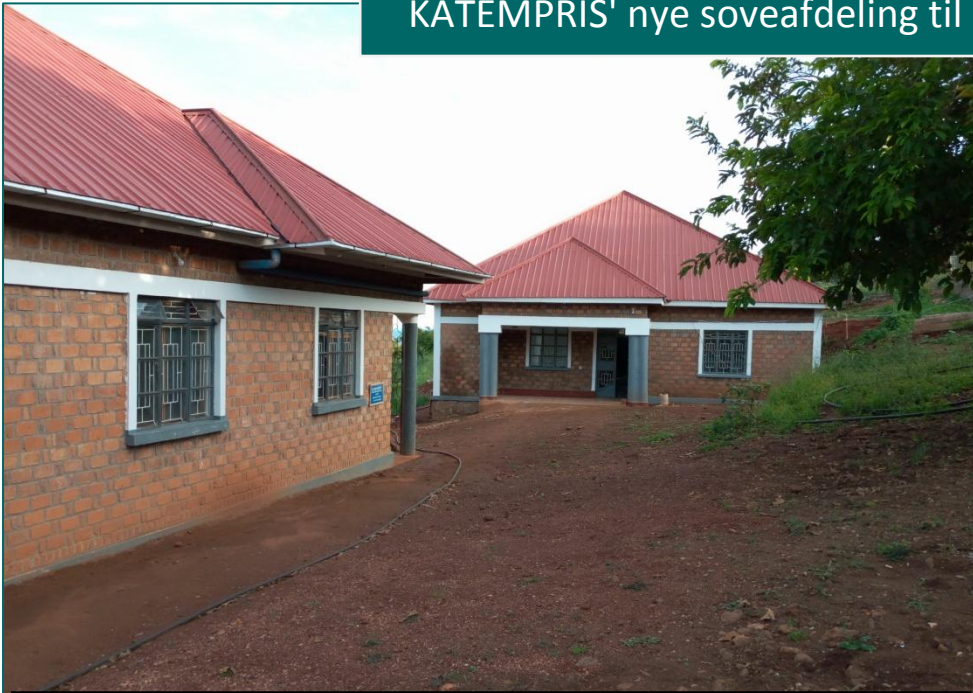
Indgangspartiet til den nye soveafdeling. Den venstre bygning er den eksisterende soveafdeling.
